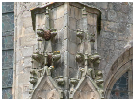
Imagen 78. Enjambre en fachada
